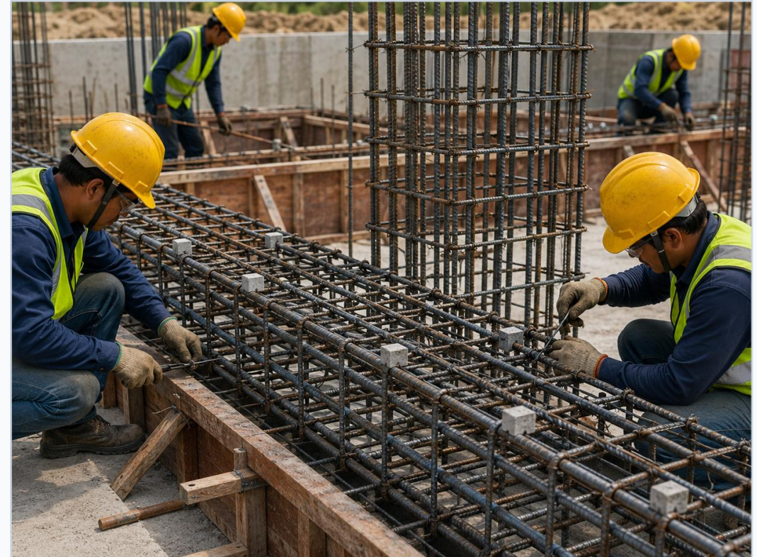
Pemasangan tulangan dengan beton decking
