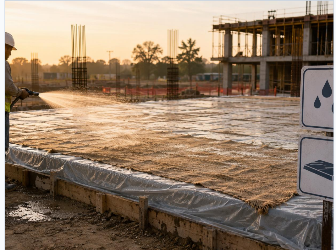
Curing dengan penyiraman dan penutup permukaan
