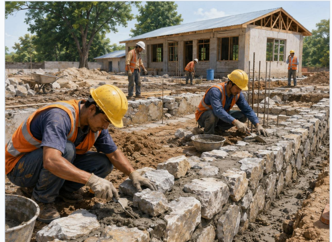
Pekerjaan pondasi batu pada area lapangan
