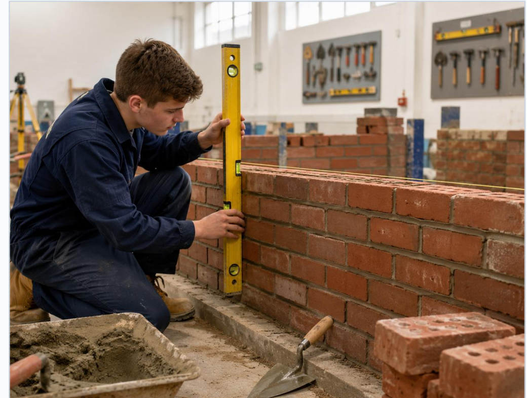
Pemeriksaan vertikalitas dengan waterpass
