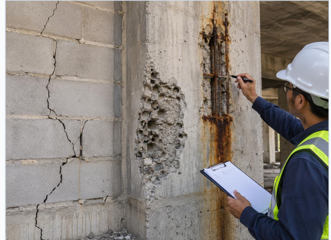
Ilustrasi cacat beton dan tulangan terbuka
