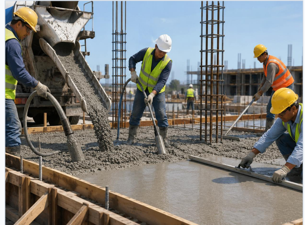
Pengecoran pelat dengan pemadatan dan finishing
