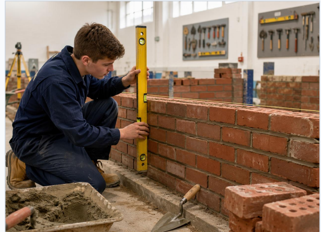
Pemeriksaan kelurusan pasangan
